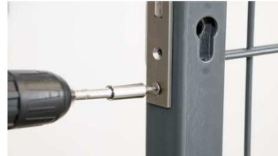
2. Montieren Sie den Profilzylinder.
